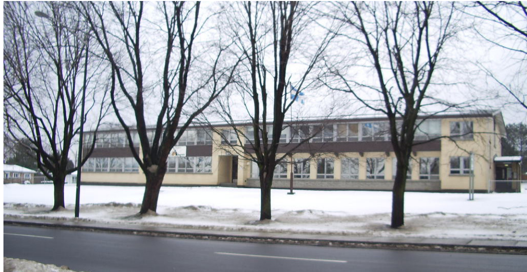
VUE FAÇADE PRINCIPALE
